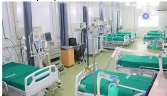
Figura 82 - Leitos UTI – Hosp. de Campanha de Rondônia (Cero)
